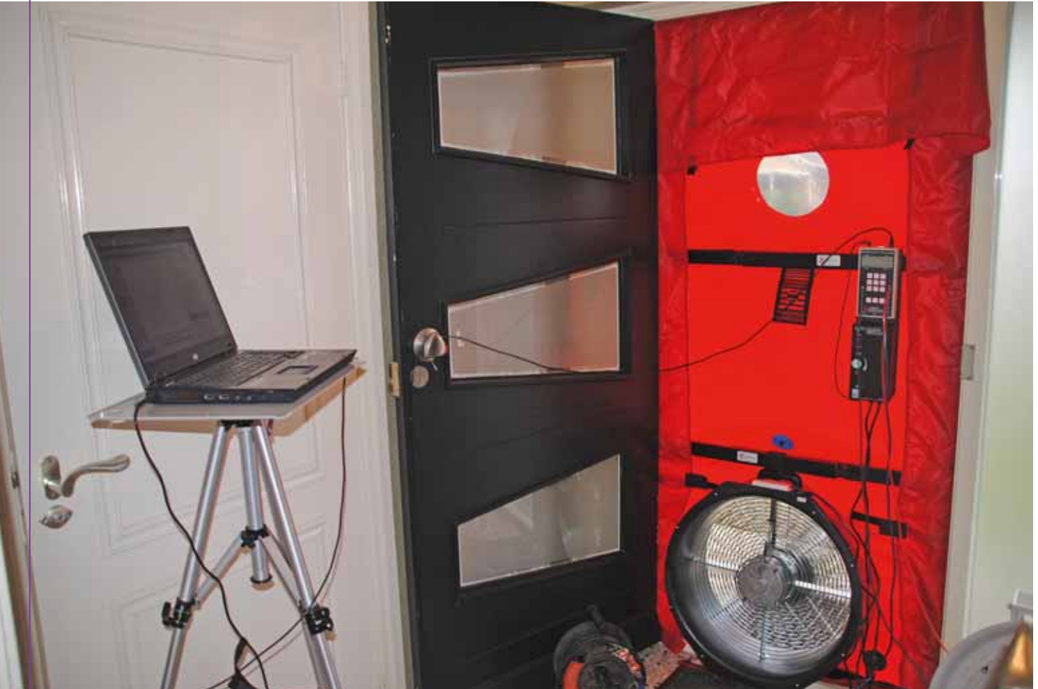
Blowerdoortest om luchtdichtheid te meten.
